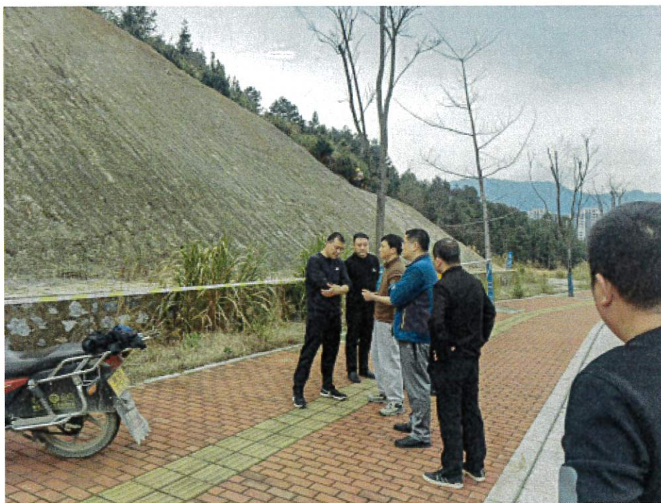
炎陵县康乐大道现场修复前照片 2（近景）
