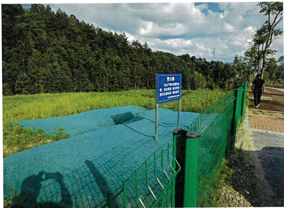
炎陵县康乐大道现场修复后照片 2（近景）
