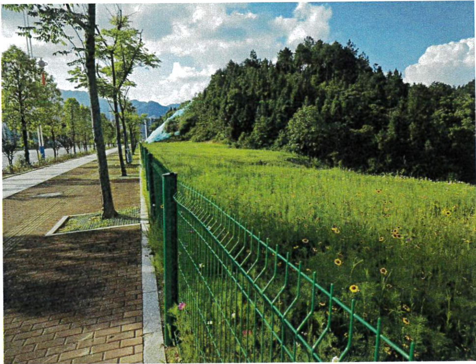
炎陵县康乐大道现场修复后照片 1（近景）
