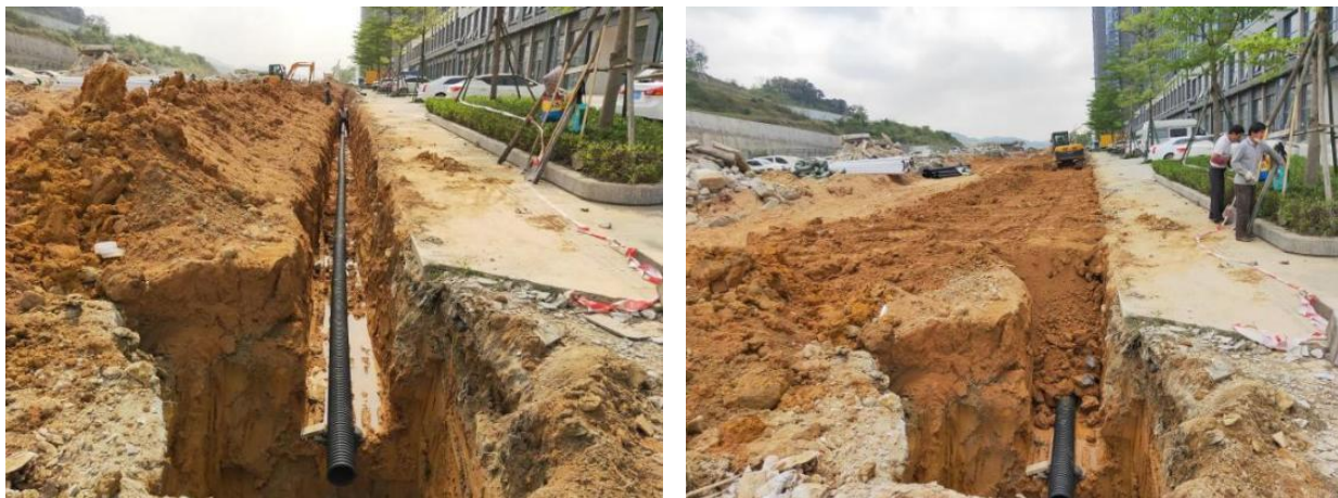
图 6-7 硬质透水管示意图
