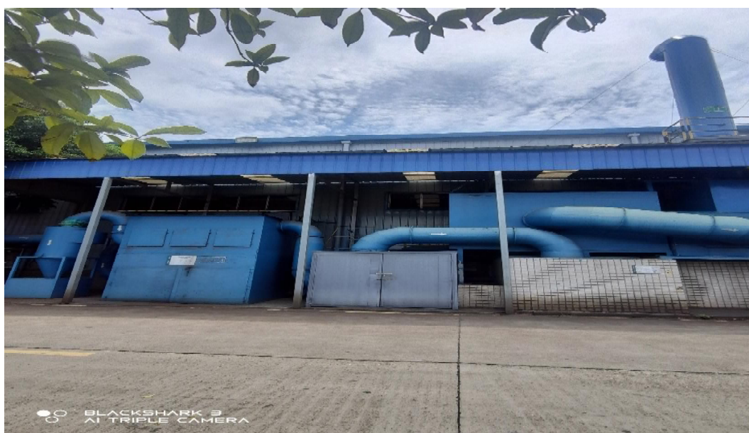
3、连续梁悬链式抛丸机除尘系统（排口编号DA003）
