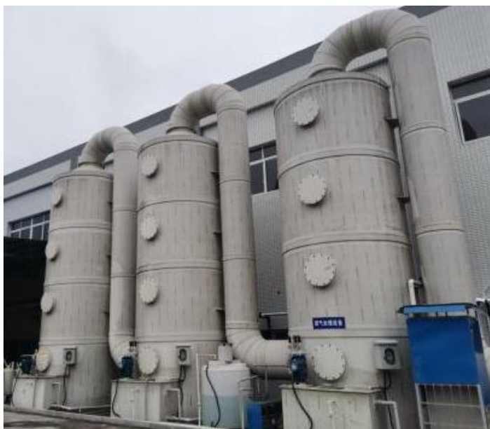
图 4-2 同类工程三级碱液喷淋塔现场照片
