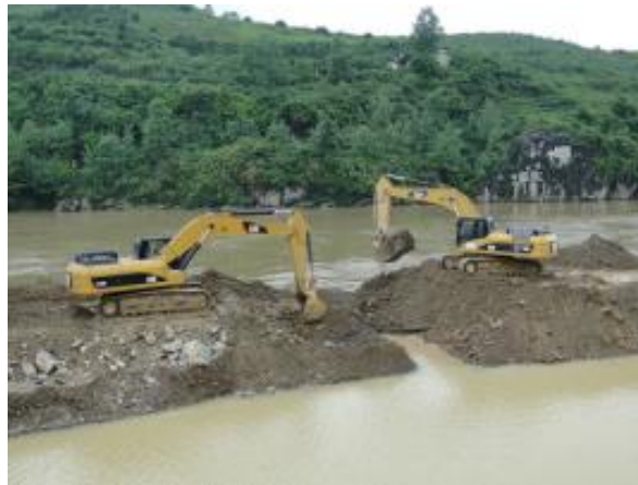
图3.3.1-1施工围堰图
