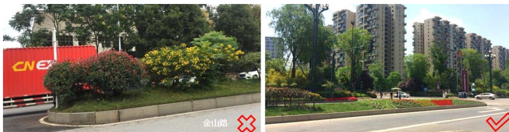
图 2.7.1-1 分车绿带端头诱导度的反例与正例
