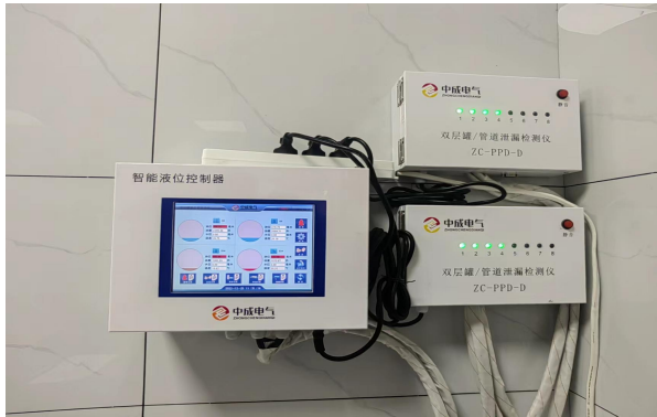
液位仪及管道泄漏检测仪
