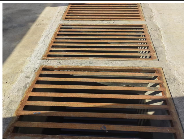
洗车废水隔油沉淀池
