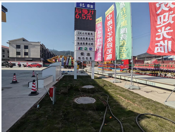
清洗废水、初期雨水隔油沉淀池
