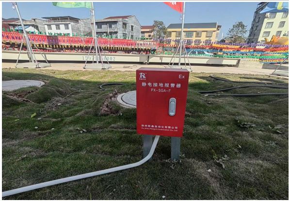
卸油口静电接地报警器
