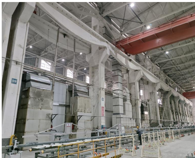
油漆房废气处理设施
