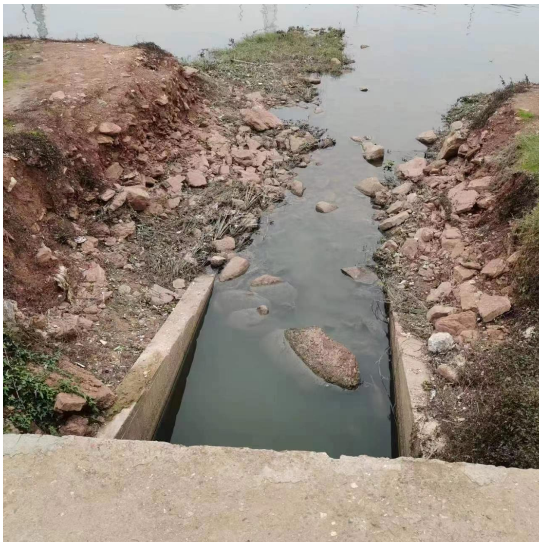
整改后的鹅颈洲排渍站入河排口
