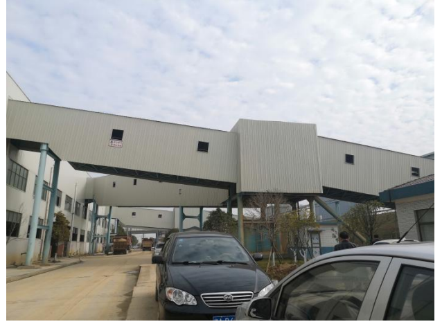
图 6.1 参照同类厂皮带输送机防护罩示意图
