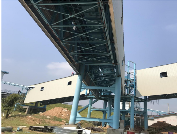
图 6.1 参照同类厂皮带输送机防护罩示意图
