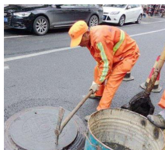
图 2-16 达标类-清理淤堵窨井、更换窨井盖意向图
