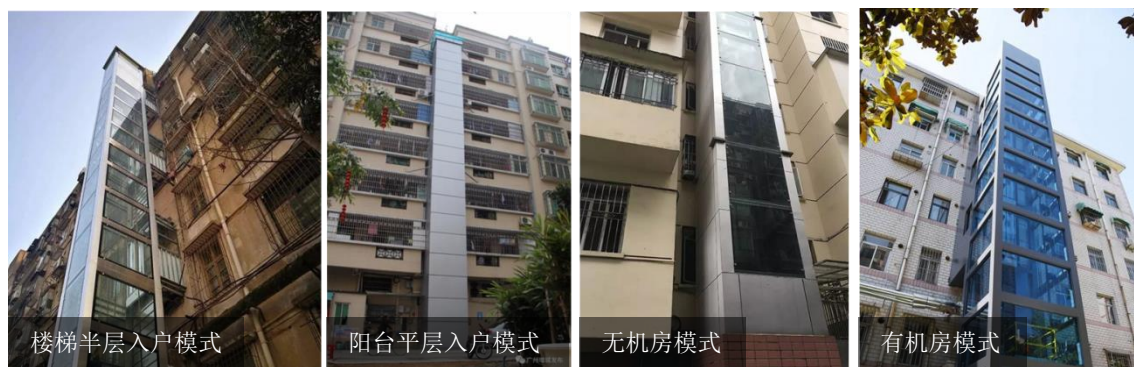
图 2-139 小区电梯加装方案意向图
