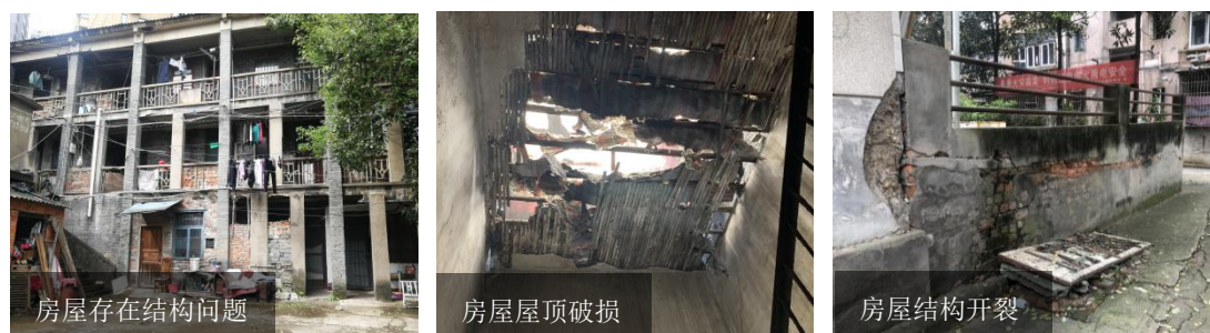
图 2-3 房屋结构存在问题负面清单
