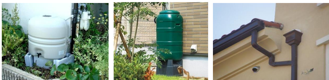
图 2-111 屋面雨水收集设施改造意向图
