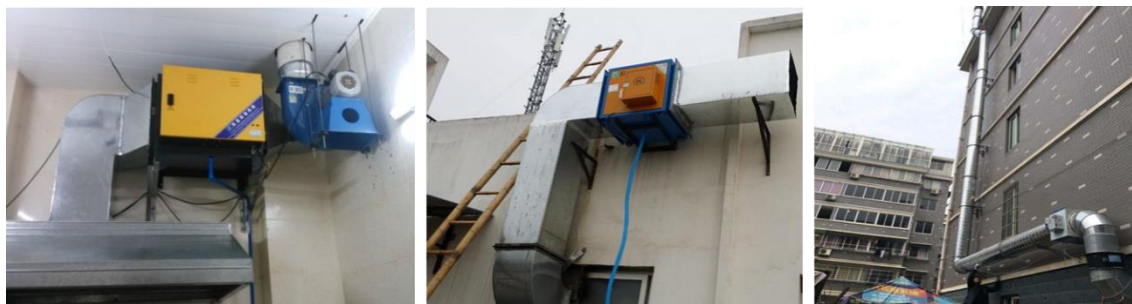
图 2-102 小区油烟机改造意向图
