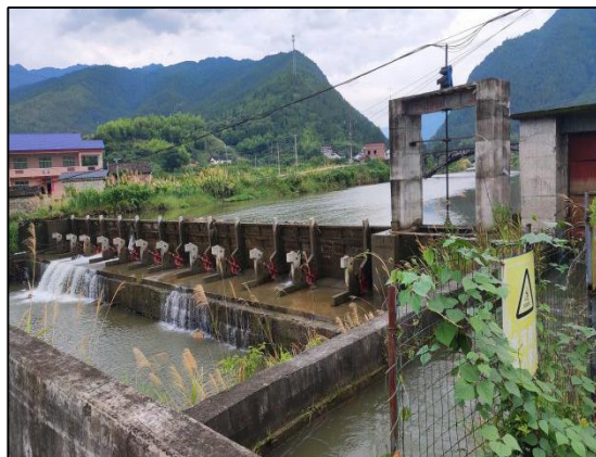
拦河坝上游坝址植被恢复情况
