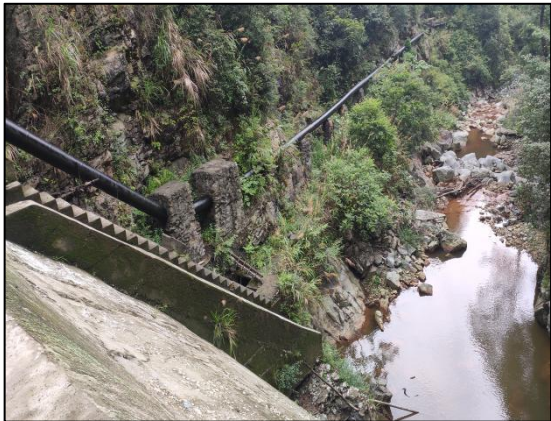
淞江水电站 1#拦河坝
