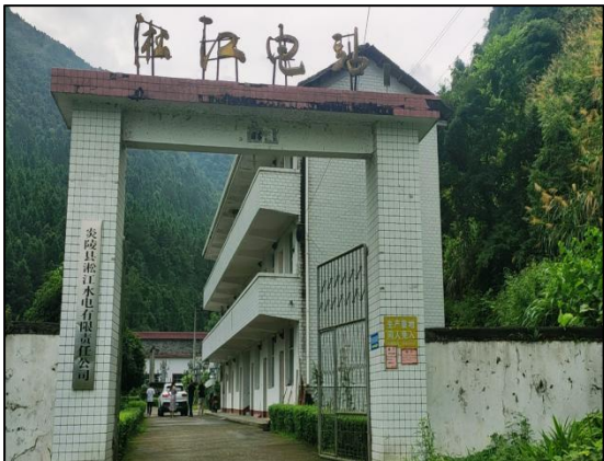
淞江水电站厂房
