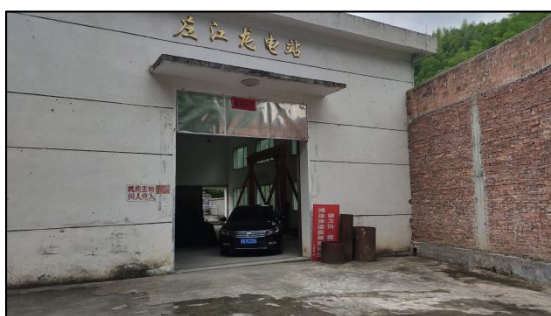
左江龙水电站厂房
