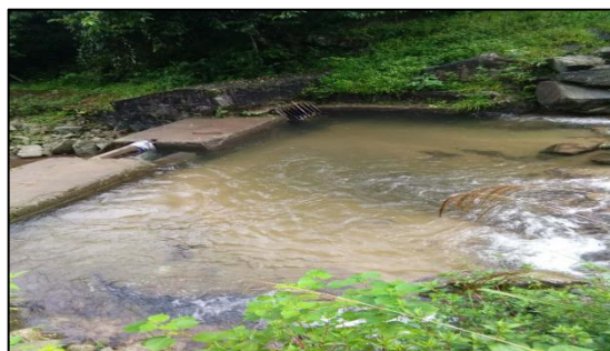
左江龙水电站拦河坝
