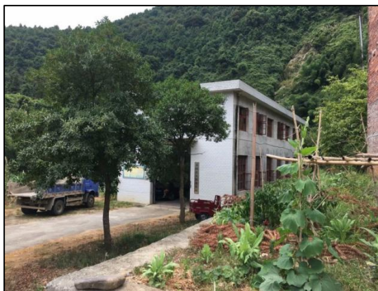
大源水电站厂房
