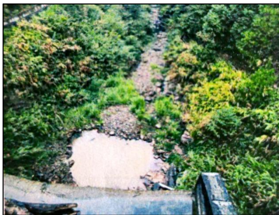
拦河坝坝址植被恢复情况
