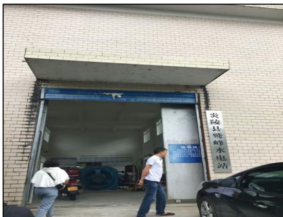
鸢峰水电站厂房
