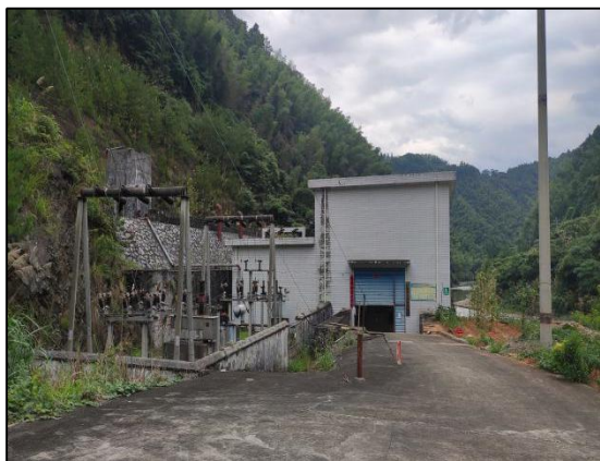
太和塘水电站厂房
