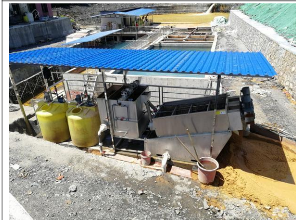
现有地面矿涌水处理站污泥压滤机
