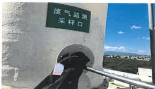
20060307H01-07 碱性废气排气筒 2#出口
