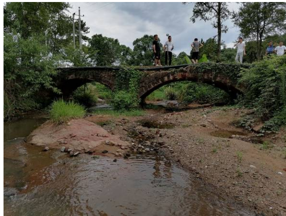
图 1-1 古柏桥侧面照片
