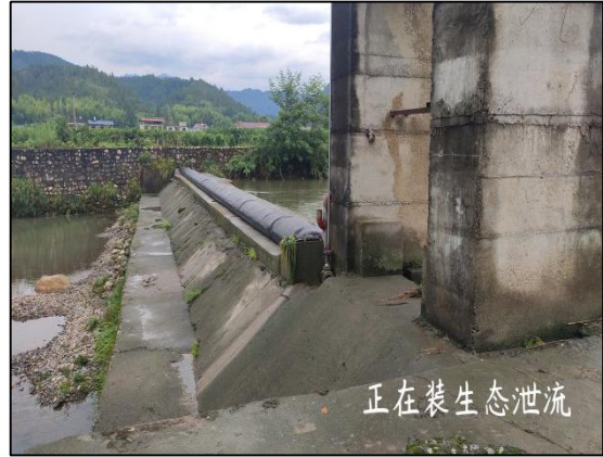
青山下水电站拦河坝
