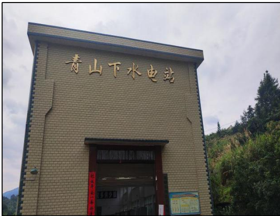
青山下水电站厂房
