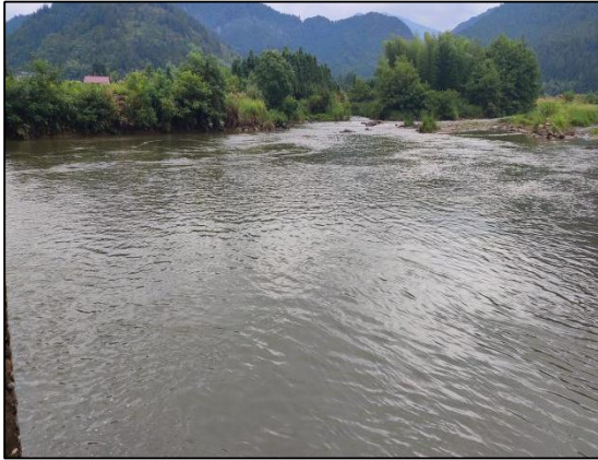
拦河坝坝址植被恢复情况
