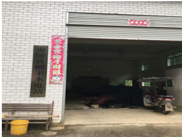
棚下水电站厂房
