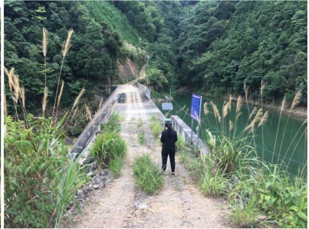
棚下水电站拦河坝
