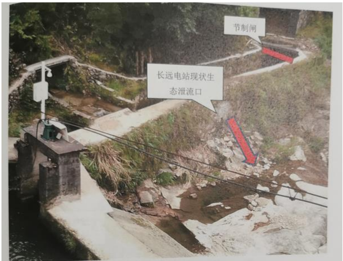
图 5.1-1 生态流量泄放设施示意图
