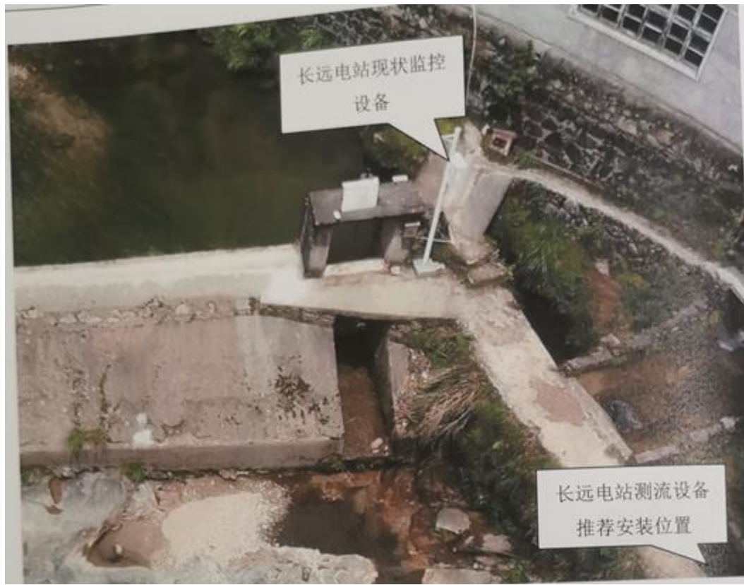
图 5.1-2 长远电站监测设备安装位置图
