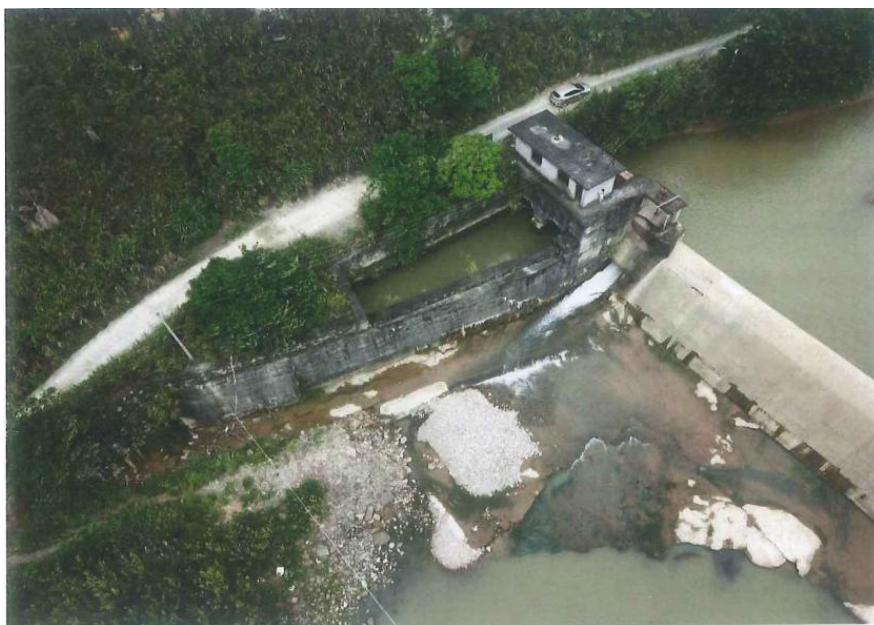
图 5.1-1 月洲湾电站大坝、引水明渠及冲砂闸
