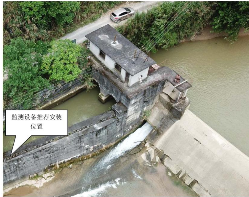
图 5.1-4 月洲湾水电站监测设备安装位置图
