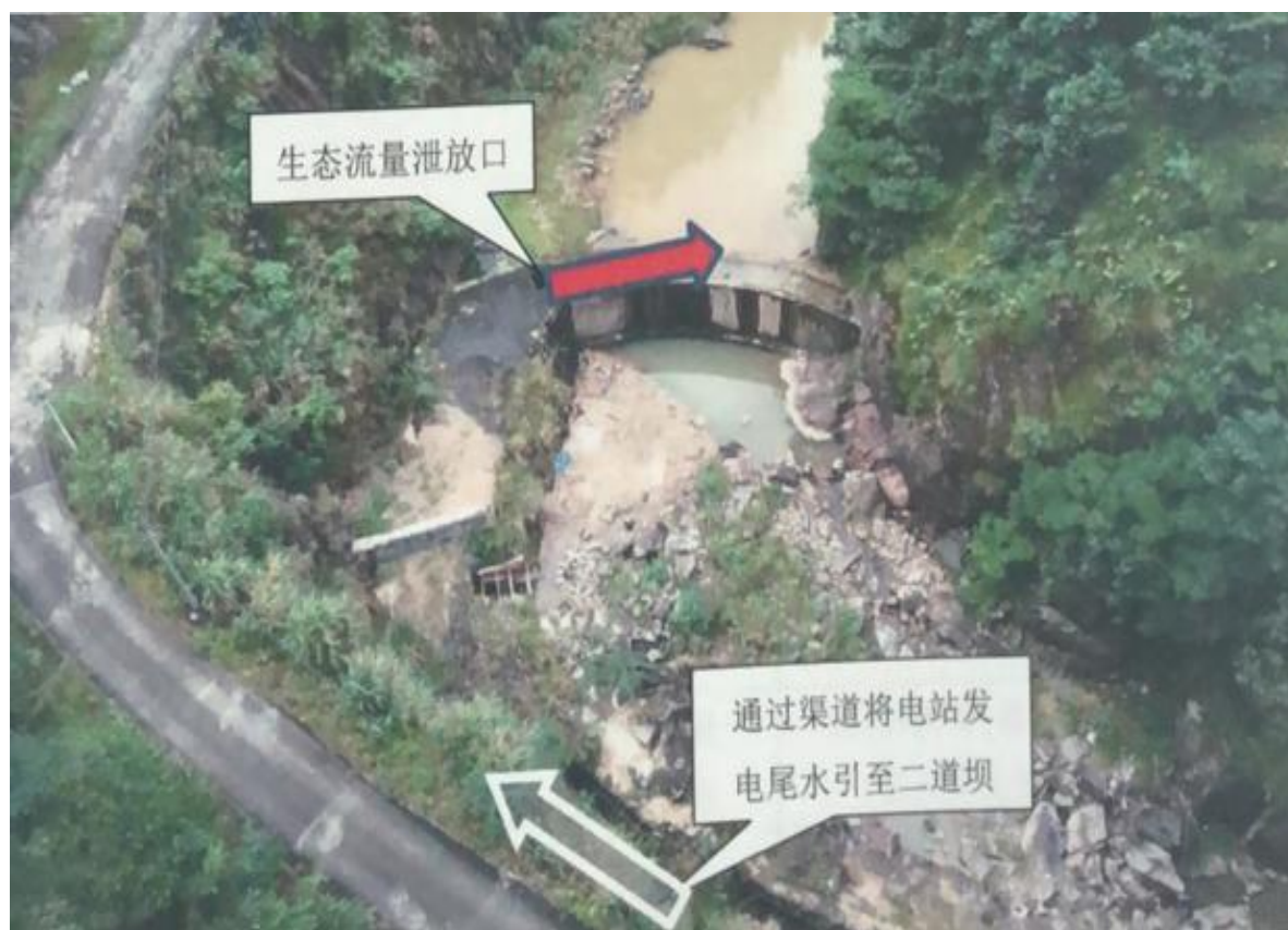
图 6-1 厂房尾水引至二道坝下泄生态流量示意图
