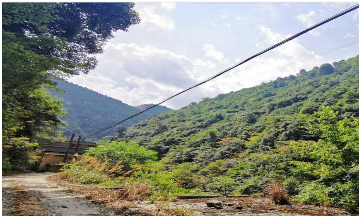
图 6-4 发电厂房及升压站附近生态恢复情况图
