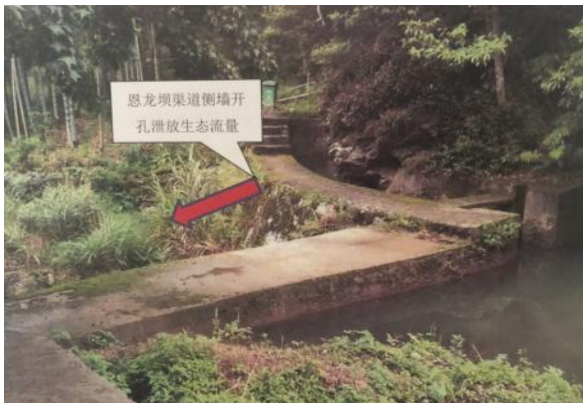
图 6-1 恩龙坝渠道侧墙开孔泄放生态流量示意图
