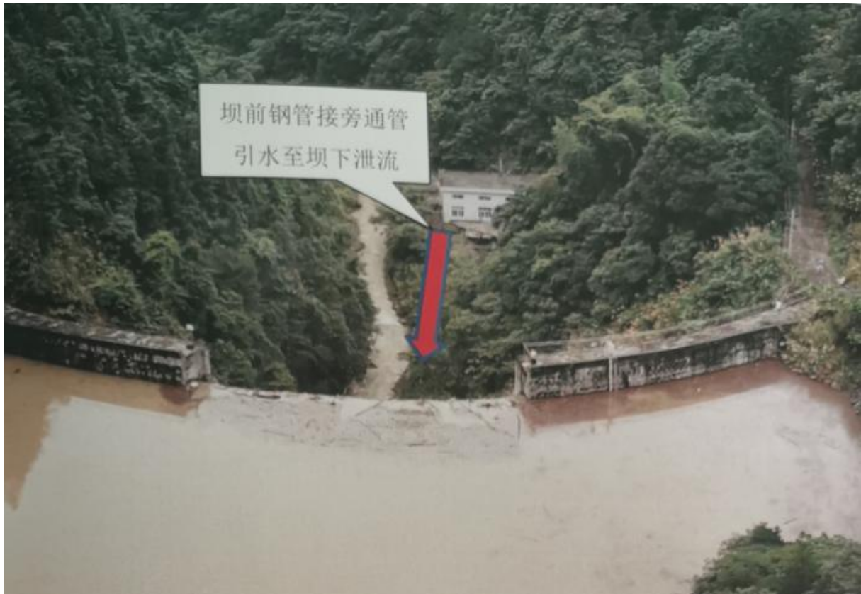
图 5.1-2 鲁坑一级电站生态泄流改造方案示意图
