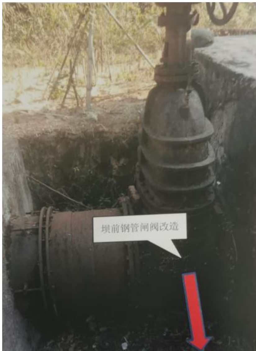
图 5.1-1 天堂电站出水支管改造示意图
