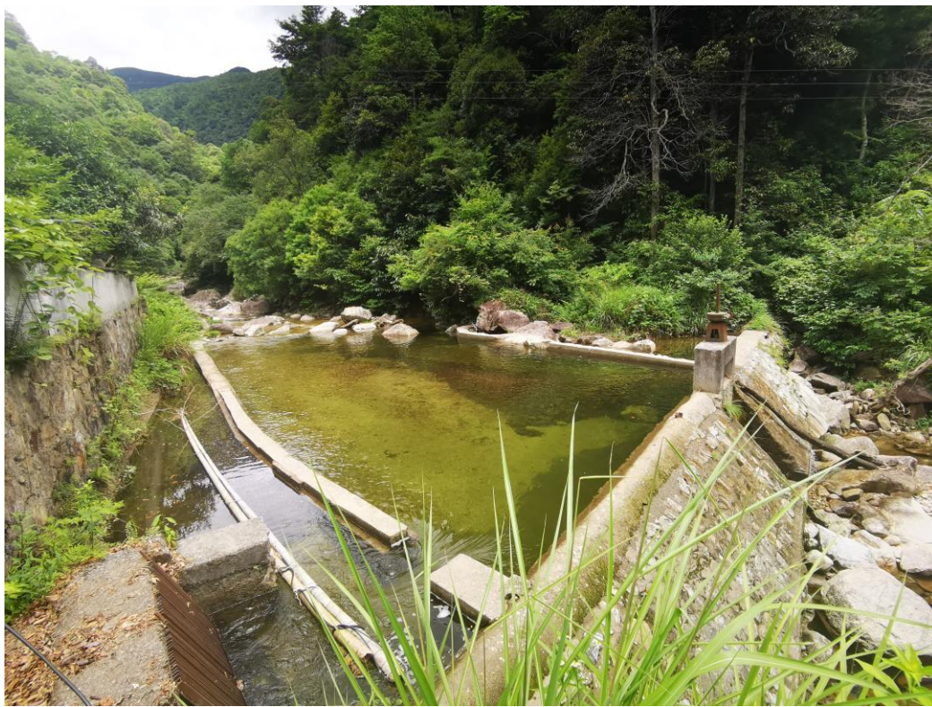
图 2.1-2 资兴河坝现状
