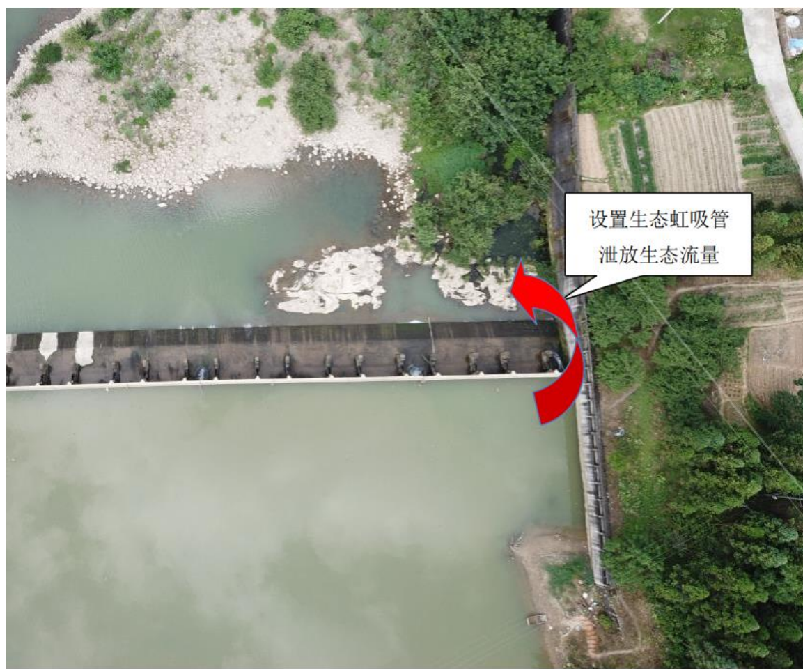
图 5.1-1 安装生态虹吸管方案示意图
