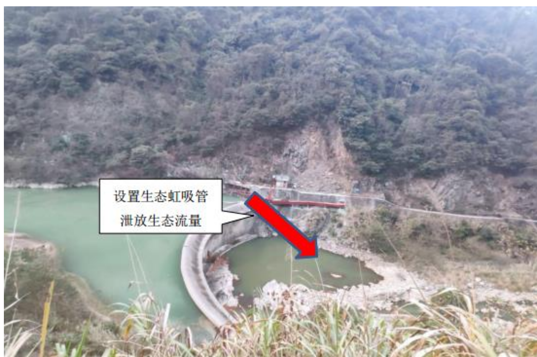
图 5.1-1 安装生态虹吸管方案示意图
