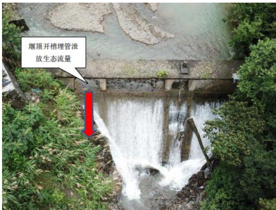
图 5.1-1 堰顶开槽埋管示意图
