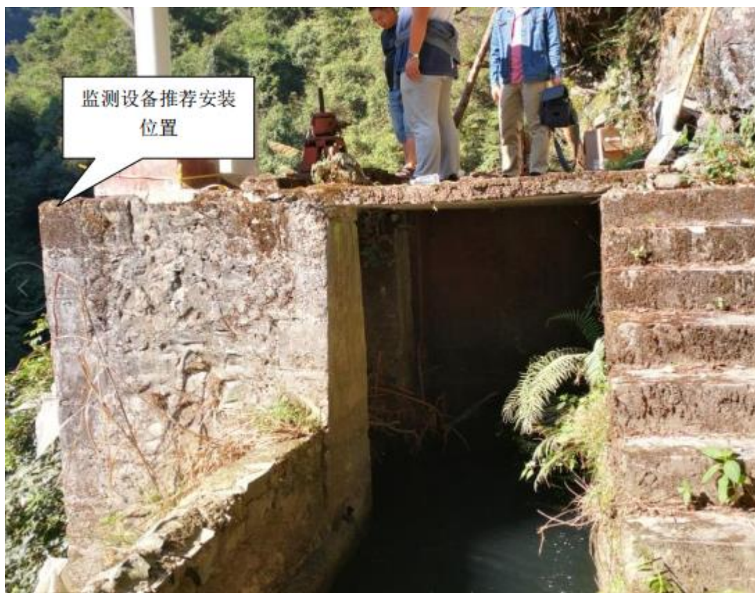
图 5.1-2 罗浮江水电站监测设备安装位置图
