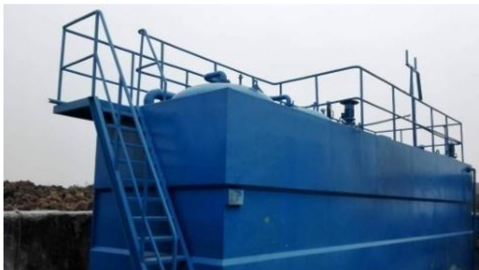
图 1-1 移动式一体化重金属废水处理设备
