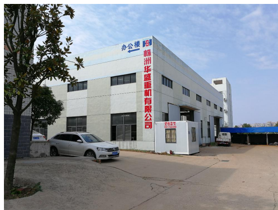
西侧株洲华盛重机有限公司
